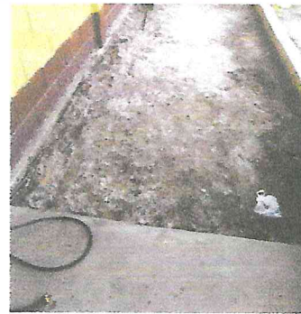
Foto 4: Reparación de planchas de concreto de patio
