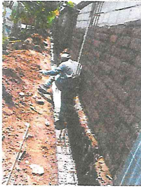
Foto1: Reparación del muro perimetral de block
