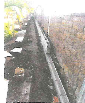
Foto 2: Reparación de muro perimetral de block
