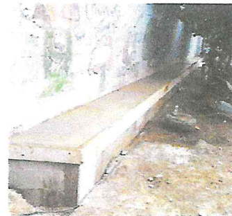
Foto 6: Reparación de banquetas de concreto
